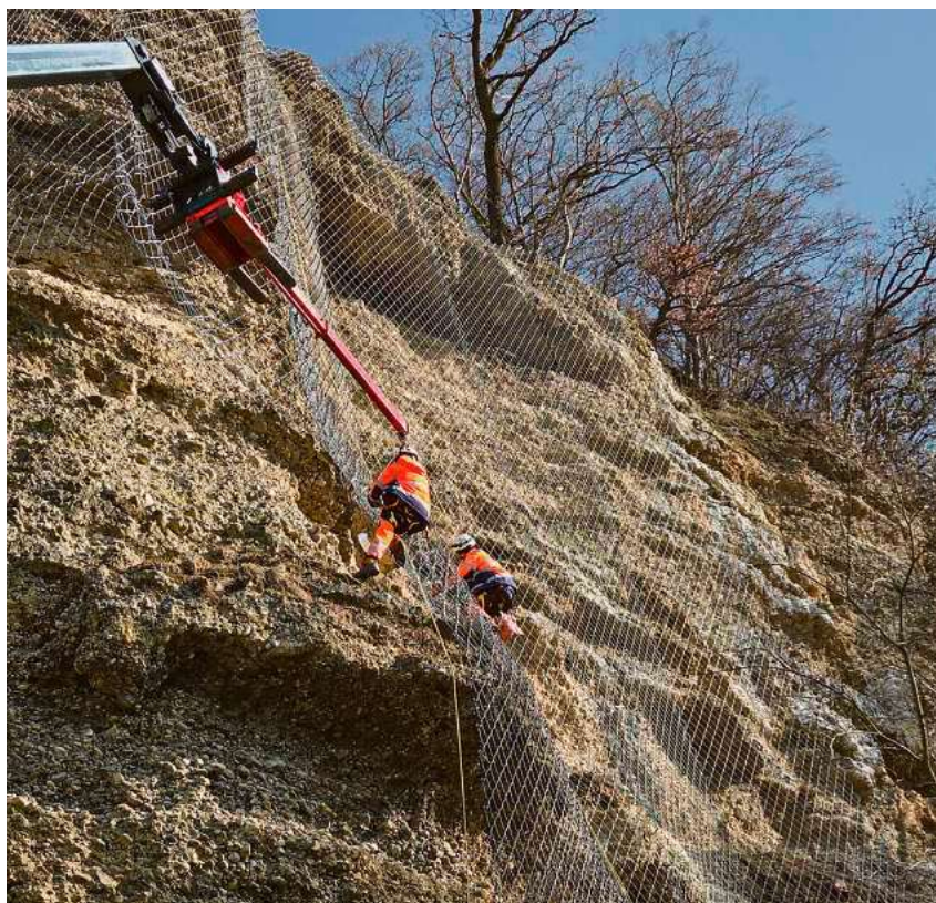
Ein großes Stahlnetz sichert die Nagelfluhwand in der Ulmer Straße. Arbeiter verbinden die einzelnen Netzrollen in luftiger Höhe. Fotos: BIKO
