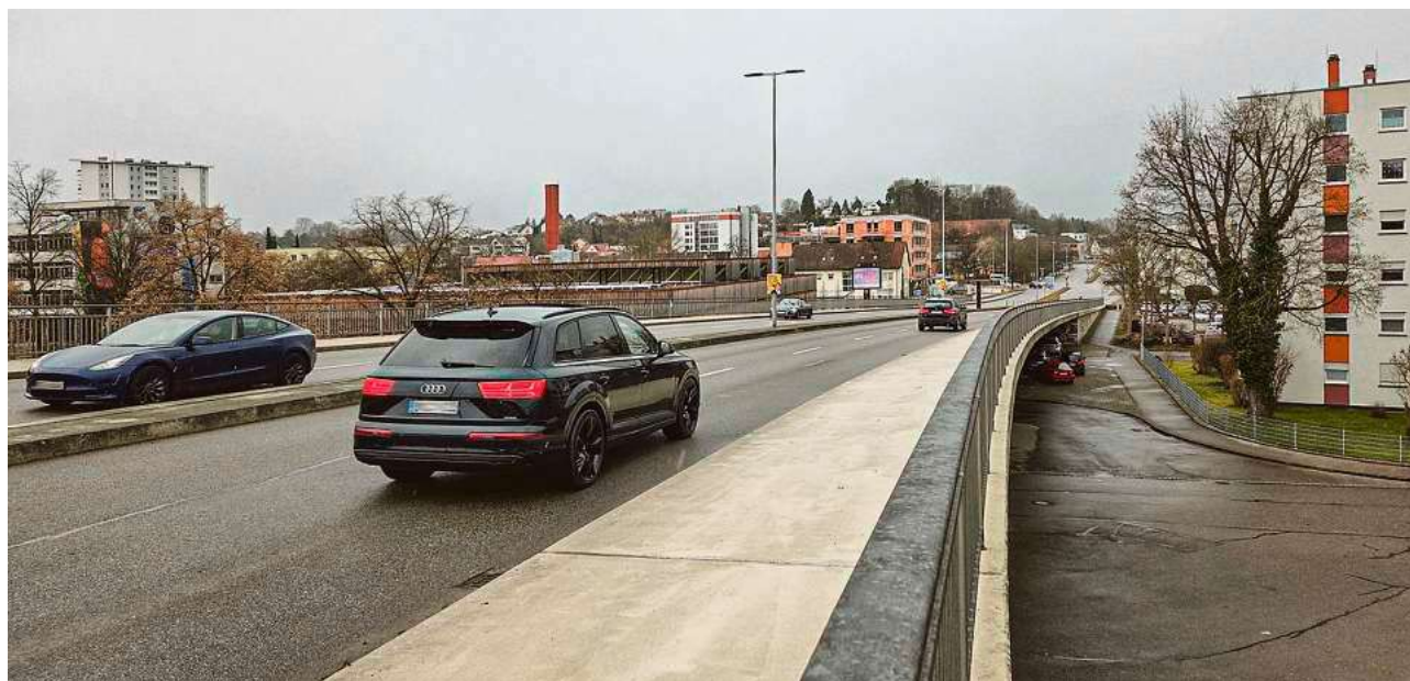
Die beiden Brücken in der Königsbergallee müssen saniert werden. Die Stadt lässt jetzt untersuchen, wie groß der Sanierungsbedarf tatsächlich ist.
