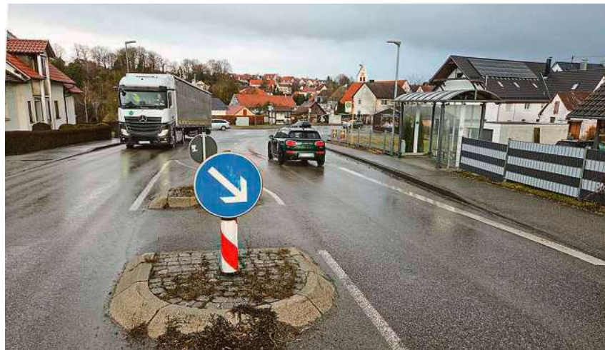
Die Bushaltestelle in Ringschnait an der B312 von Biberach kommend wird ebenso barrierefrei umgebaut wie die angrenzende Querungshilfe. Foto: BIKO
