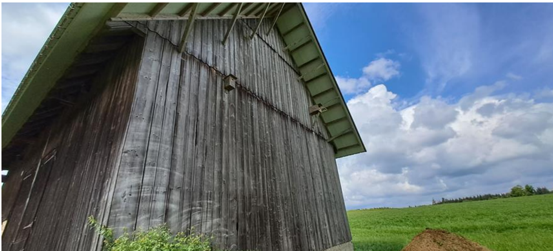
Ostfassade der Scheune mit zwei Vogelnisthilfen (rechts besetzter Turmfalkenkasten)
