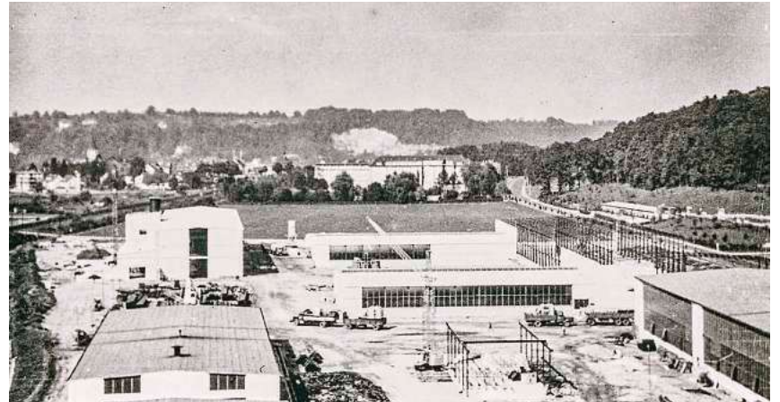
Bau des Liebherr-Kranwerks in Biberach in den Jahren von 1954 bis 1956.
