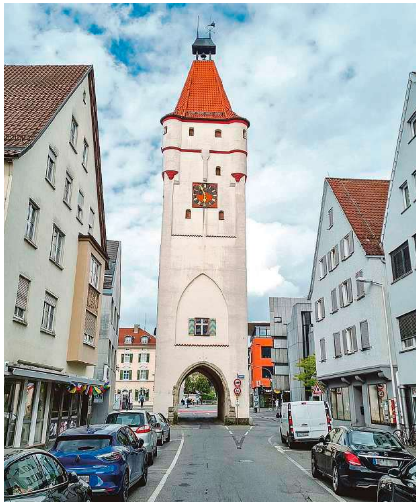
Das Ulmer Tor braucht wieder einen sicheren Untergrund. Die Arbeiten zur Gründungssanierung sollen im Herbst starten. Foto: BIKO
