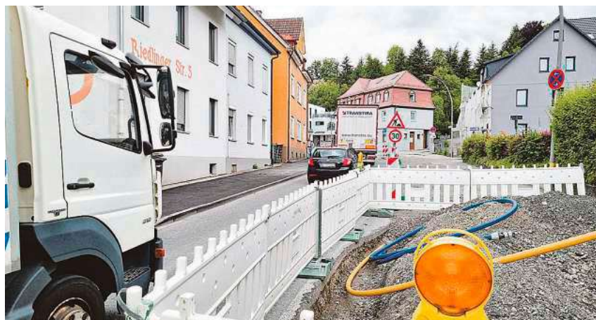
Die e.wa riss Netze verlegt in der Riedlinger Straße zwischen der Kreuzung Theaterstraße und der Kreuzung Hardtsteigstraße eine neue Trinkwasserleitung und eine neue Gasleitung. Foto: BIKO
