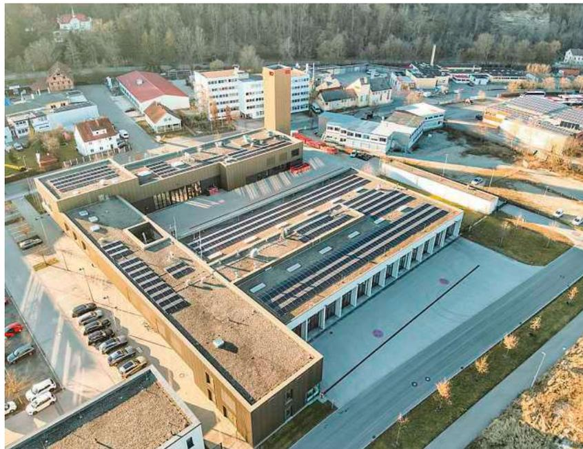
Auf dem Dach der Biberacher Feuerwehrhaus befindet sich eine PV-Anlage mit einer Leistung von 260 Kilowatt-Peak. Foto: Feuerwehr Biberach, Drohnenaufnahme
